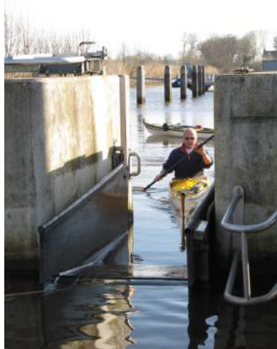
De kanostuw naast de sluis bij Schaphalsterzijl
