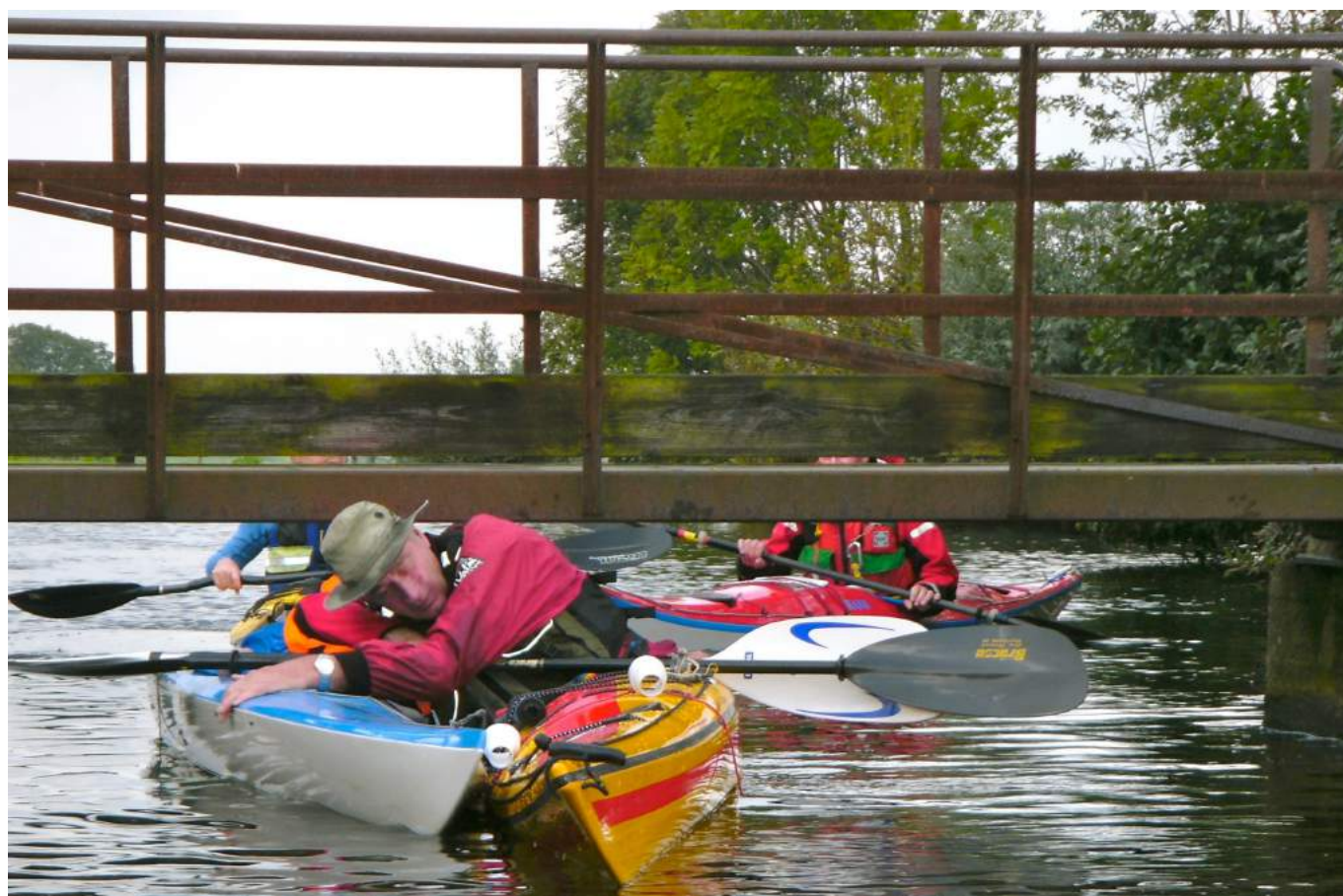
Een lage brug is een hindernis voor kanovaarders
